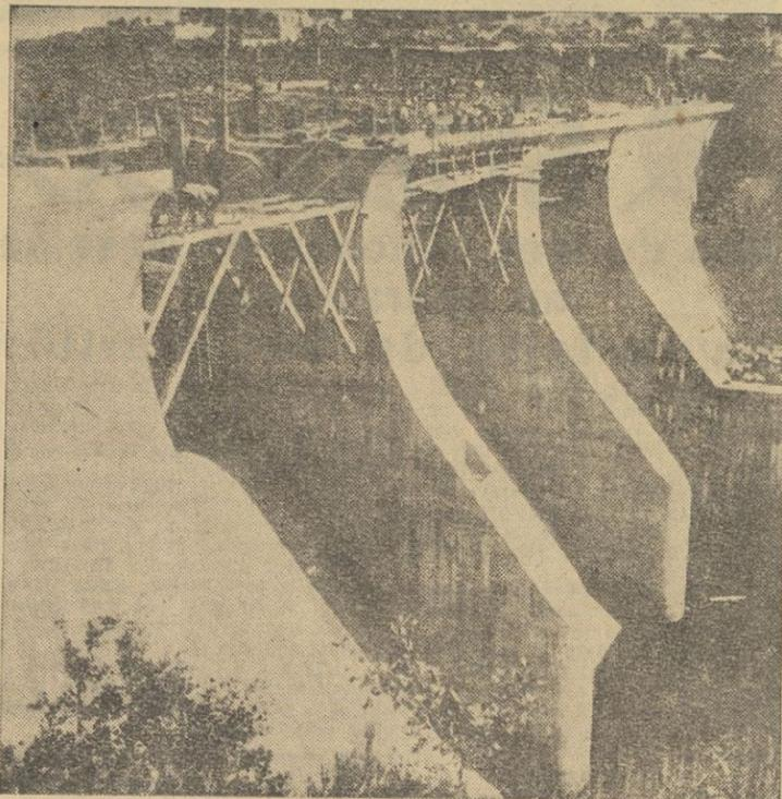
Presa del pantano de Rosquito, sobre el Tietar, de 24 metros de altura y 72 de longitud, que podrá embalsar 84 millones de metros cúbicos de agua, lo que permitirá un riego de 17.000 hectáreas de las vegas de la Vera y Navalmaral de la Mata. El salto de agua generará 17 millones de kilovatios-hora al año. Dicho pantano, fué inaugurado en días pasados por el Ministro de Obras Públicas
