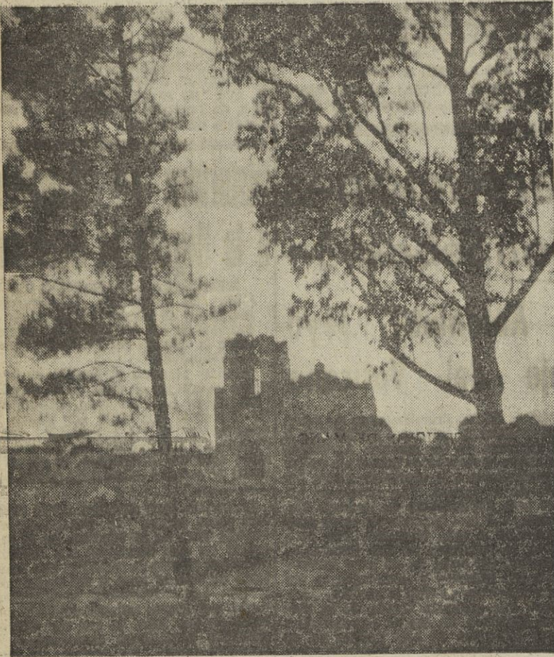
La basílica de la Vera-Cruz se yergue en una de las zonas de mayor porvenir de Carballino. A unos doscientos metros se halla completamente terminada la estación del ferrocarril Coruña - Zamora
