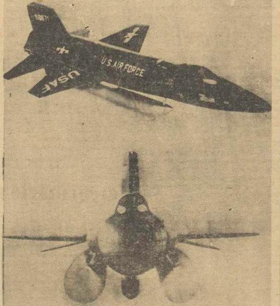
Dos vistas del nuevo avión de gran altura X-15 con sus tanques de combustible externos que permitirán al aparato duplicar su fuerza de impulsión. Se espera que alcance la velocidad de 8.120 kilómetros por hora. La máxima velocidad alcanzada por el X-15 hasta ahora había sido de 3.624 kilómetros por hora. — (FOTOFIEL)
