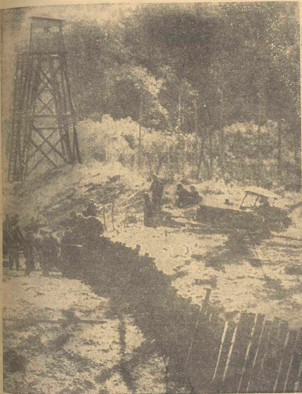
Un nuevo obstáculo antitanques se está construyendo en el sudoeste de Berlín. (FOTO FU-ROPA PRESS).
