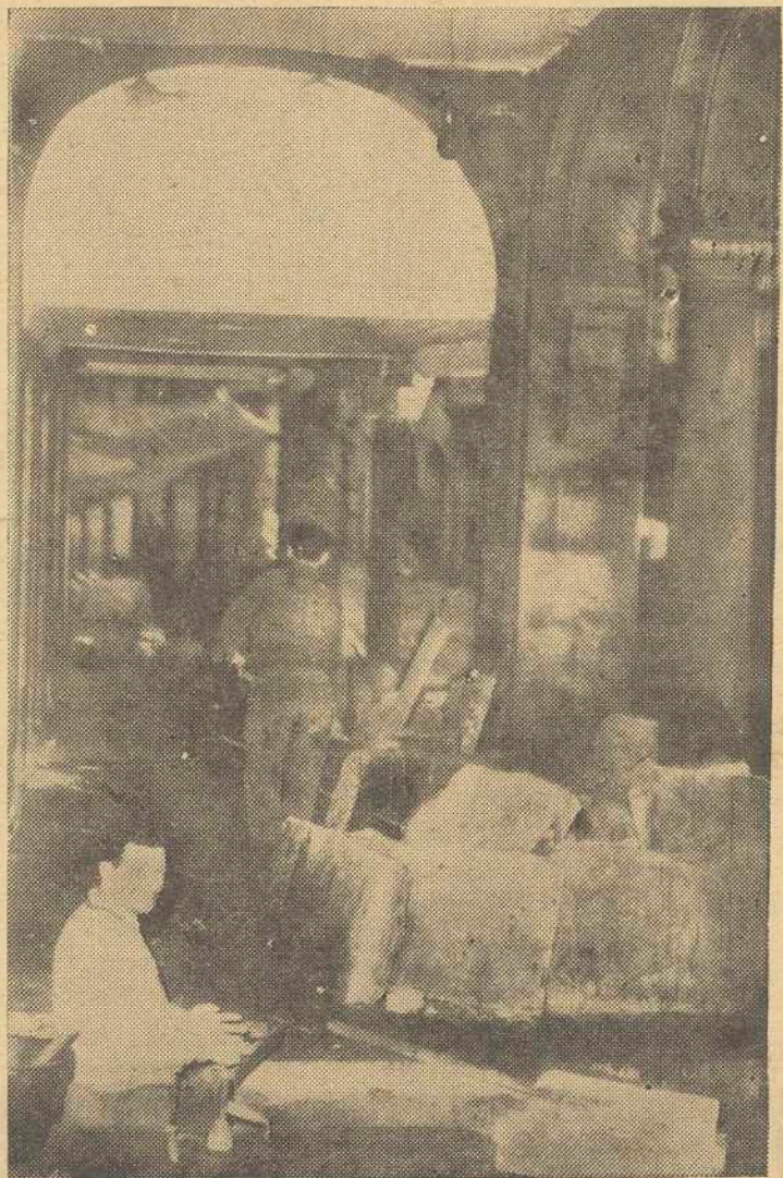
Dos obreros trabajando en la Rúa del Villar del Villar bajo los soporales.
