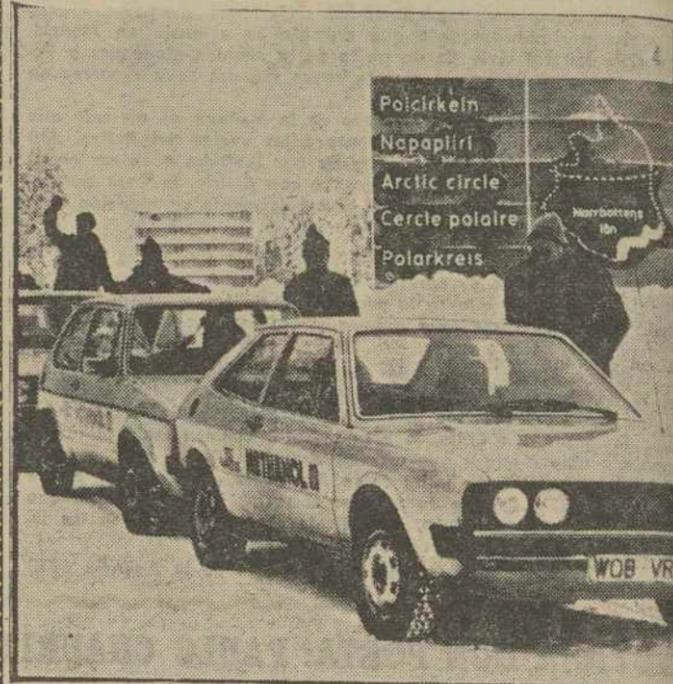
Cuarenta y cinco automóviles de los diversos tipos fabricados por la Volkswagen acaban de participar en un recorrido experimental, en pleno círculo polar, para poner a prueba un nuevo combustible, mezcla de la tradicional gasolina con un quince por ciento de metanol. El precio resulta, al parecer, ligeramente más alto, pero se comprobó un ahorro energético y, sobre todo, una mayor limpieza en el aire. ~ (FOTOFIEL-INTERNAT)
