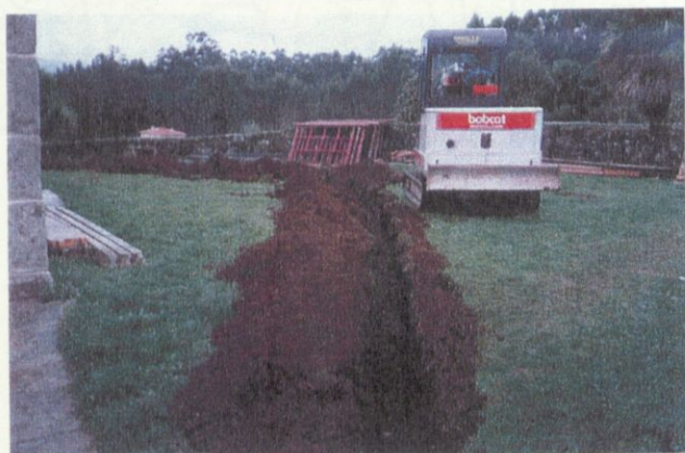
Zanja realizada en el lateral S del edificio.
