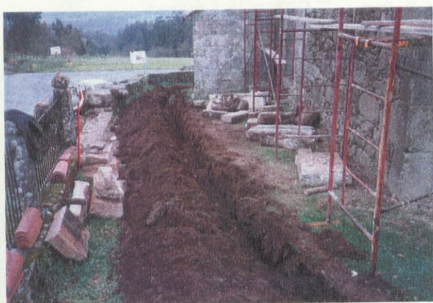
Zanja realizada en el lateral N del edificio para instalar conducciones eléctricas.
