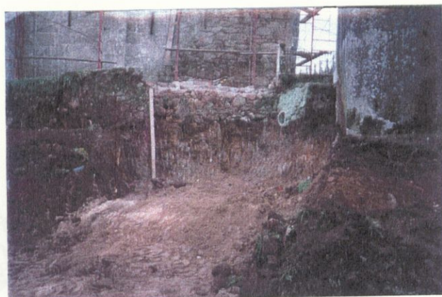
Desmante realizado en el talud N para una pequeña edificación de servicio de la iglesia.
