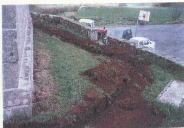
Zanja realizada en la zona exterior de la cabecera de la iglesia (lateral E).
