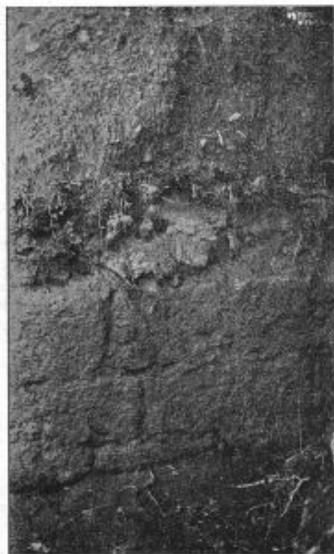
Paramento exterior do muro pol-o poñente
