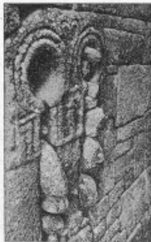
FENESTRA DA CAPELA OUSIDAL CENTRAL DE SANTA EUFEMIA DE AMBÍA
