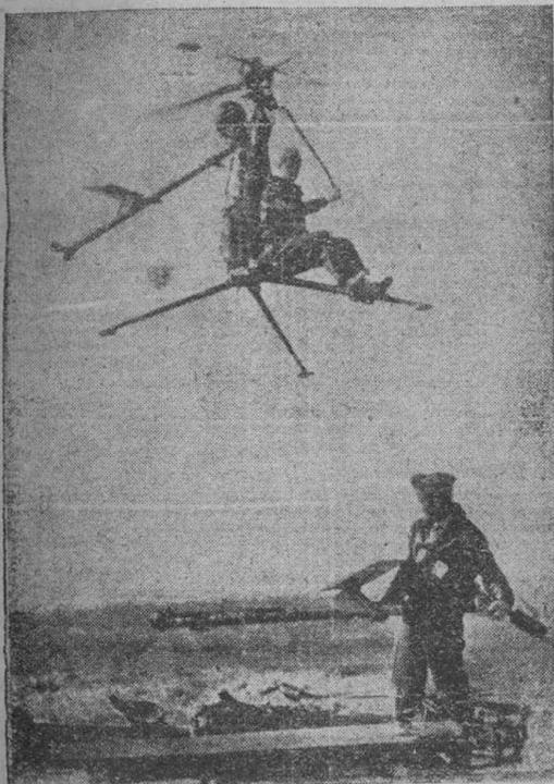
La Infantería de Marina norteamericana utiliza este tipo de helicóptero monoplaza, desmontable, que sirve para acciones paracaidistas y enlace. Tiene escaso peso y lleva un motor de cuatro cilindros a gasolina.
