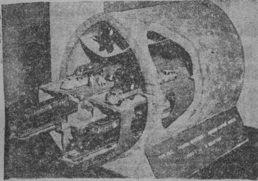
La construcción de un túnel que una a Inglaterra con Francia está de nuevo en candeler. Varios proyectos se han presentado. En la foto aparece la maqueta del ideado por el francés Bassevant. Tiene dos conductos de aireación y una doble vía férrea. En la parte central, una autopista, dividida por un andén para peatones.
