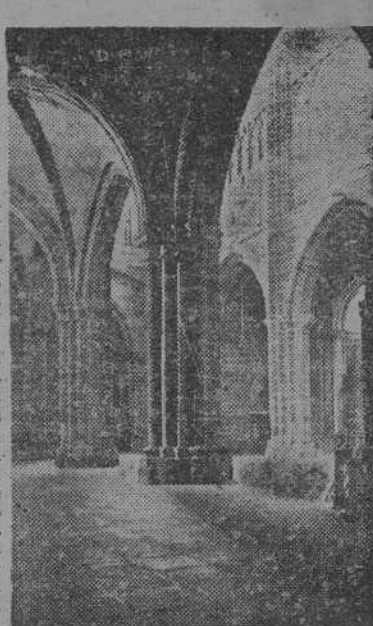
Interior de la catedral de Avila, el templo-fortaleza que va a ser restaurado
