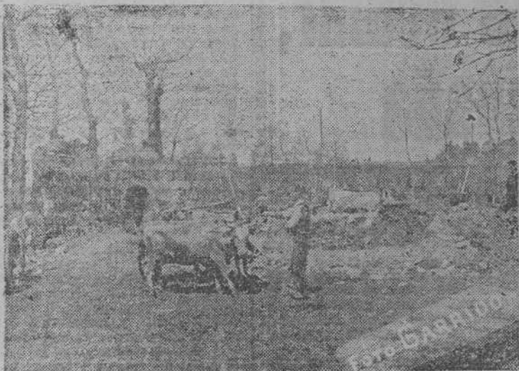
Un aspecto del último muro de la ermita de San Blas, y varios vecinos con sus carros para el transporte de las piedras a la nueva iglesia parroquial
