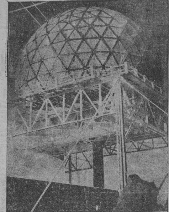
Es aquí una de las estaciones de radar correspondientes a la red de defensa aérea que se extiende a lo largo de 6.000 kilómetros por el continente americano. Las antenas del radar se hallan protegidas de las inclemencias del tiempo por cúpulas especiales de plástico, como la que muestra el grabado.
