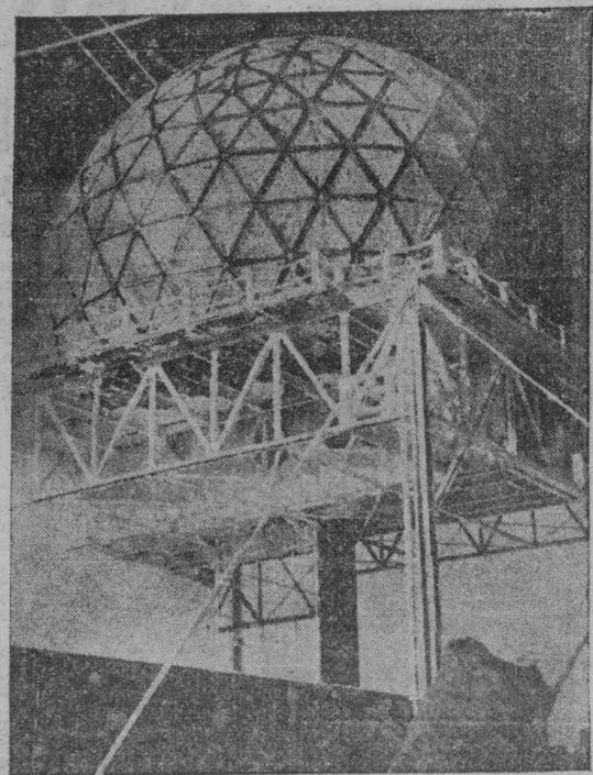
He aquí una de las estaciones de radar correspondientes a la red de defensa aérea que se extendió a lo largo de 6.000 kilómetros por el continente americano. Las antenas del radar se hallan protegidas de las inclemencias del tiempo por cúpulas especiales de plástico, como la que muestra el grabado.
