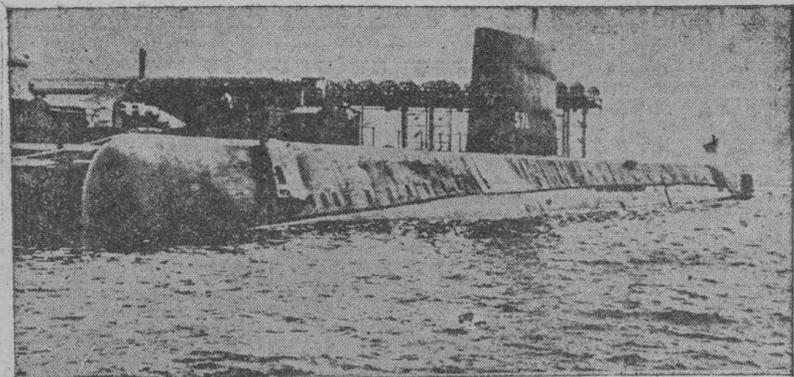
El "Nautilus", primer submarino atómico mundial, anclado en el puerto de Groton (Connecticut), dispuesto para emprender sus pruebas marítimas, la primera de las cuales consistió en ejercicios de superficie con su equipo de propulsión. El submarino está movido por fuerza atómica y ayudado con motor Diesel de energía eléctrica. (Foto Archivo)
