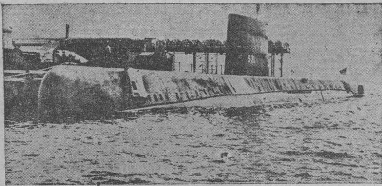
El "Nautilus", primer submarino atómico mundial, anclado en el puerto de Groton (Connecticut), dispuesto para emprender sus pruebas marítimas, la primera de las cuales consistió en ejercicios de superficie con su equipo de propulsión. El submarino está movido por fuerza atómica y a judado con motor Diesel de energía eléctrica. (Foto Archivo)
