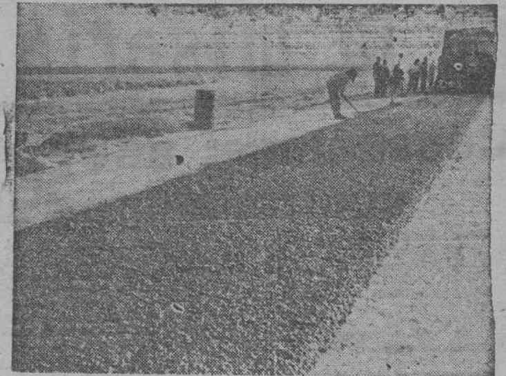
Trozo de la carretera de Socuellamos a Argamasilla de Alba (Ciudad Real), de un ancho de más de cinco metros, reparada por el nuevo sistema.
