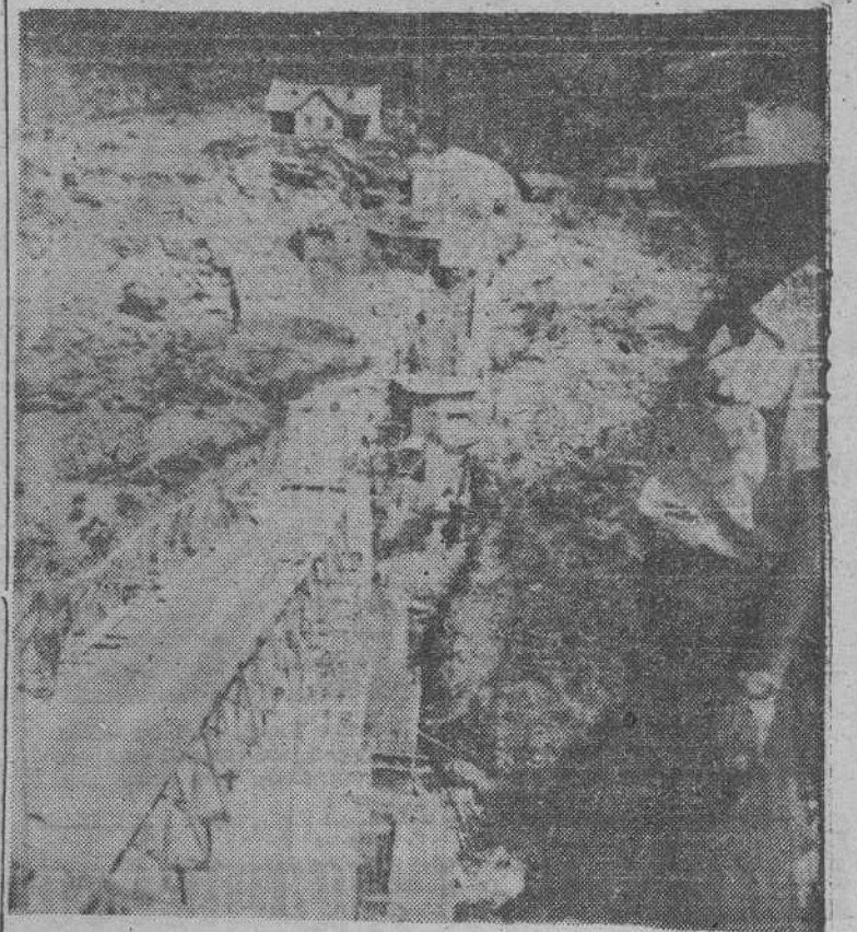
Aspecto parcial de las obras del embalse.
