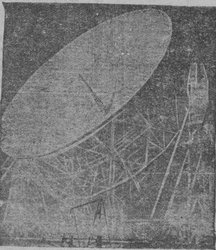
Una gran antena de radio, el nuevo radiotelescopio gigante erigido en Jodrell Bank, Cheshire, que entró en funcionamiento recientemente. Es el mayor de su clase en el mundo y ha sido diseñado para seguir automáticamente el movimiento de las estrellas a través del cielo, corrigiendo los efectos de la rotación y la traslación de la tierra.
