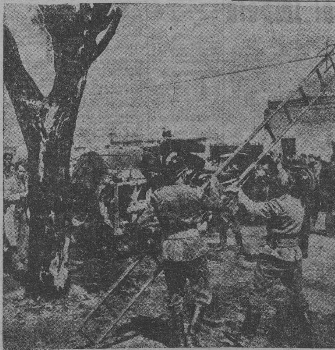
Un muerto, un herido grave y varios leves resultaron en el incendio que se produjo en un camión cisterna de la Campsa, que, en el kilómetro 5 de la carretera de Toledo, volcó al reventarse uno de sus neumáticos delanteros. Los bomberos hubieron de trabajar de firme para extinguir las llamas, que se propagaron a algunos árboles y a la fachada de una casa, y, sobre todo, tratando —por desgracia, inútilmente— de salvar al ayudante del conductor, que pereció carbonizado dentro de la cabina del vehículo.
