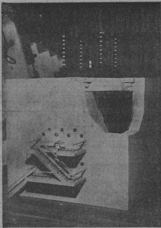
Maqueta de una pila atómica. Las gruesas paredes sirven para aislar de las radiaciones y las barras de gráfico para moderar la reacción. Puede calcularse su tamaño comparado con la figura del hombre que se observa en la escalera. (Foto EUROPA)
