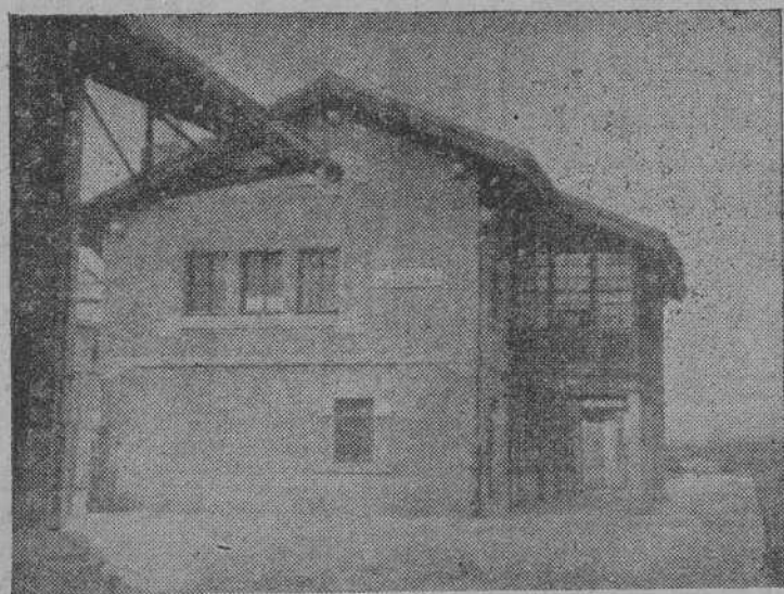
La estación de Jubia. ¿Tardará aun muchos años en registrar el paso de los trenes? Muchos edificios como éste fueron construidos a lo largo del camino proyectado. Los años hicieron notar su peso sobre ellos y ha habido que reconstruirlos. Confiamos en que éste no se verá en tal trance.
