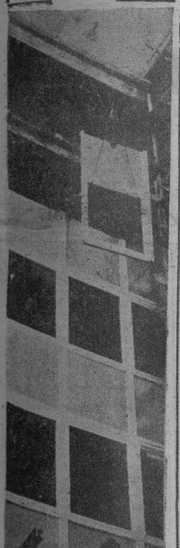
Cuatrocientos cincuenta y siete piezas componen esta fachada, totalmente prefabricada, que ahora se instala en un edificio de Alemania. La fachada pesa treinta y cinco toneladas y se puede montar en 10 días
