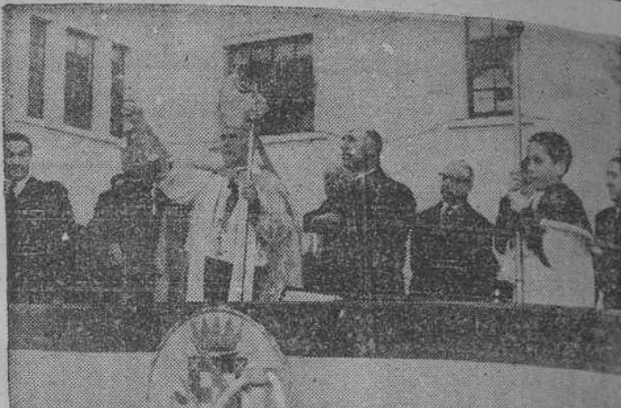
El Obispo de la Diócesis, Dr. Argaya Golcochea, en el momento de la solemne bendición del grupo de viviendas construido por la Empresa Nacional Bazán, que fue inaugurado el jueves en El Ferrol.
