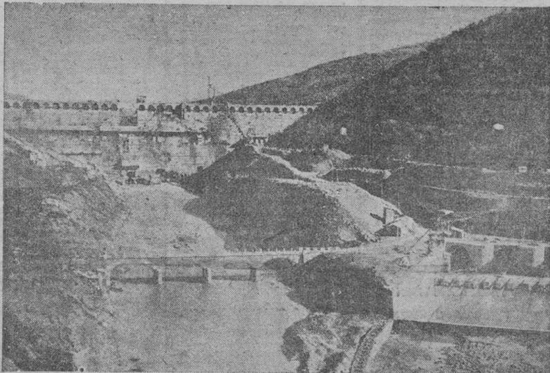
El pantano de Yesa, con una presa de gravedad sobre el río Aragón de setenta metros de altura y más de cuatrocientos de longitud. Embalsa 470 millones de metros cúbicos y en ella toma sus aguas el canal de las Bardenas
