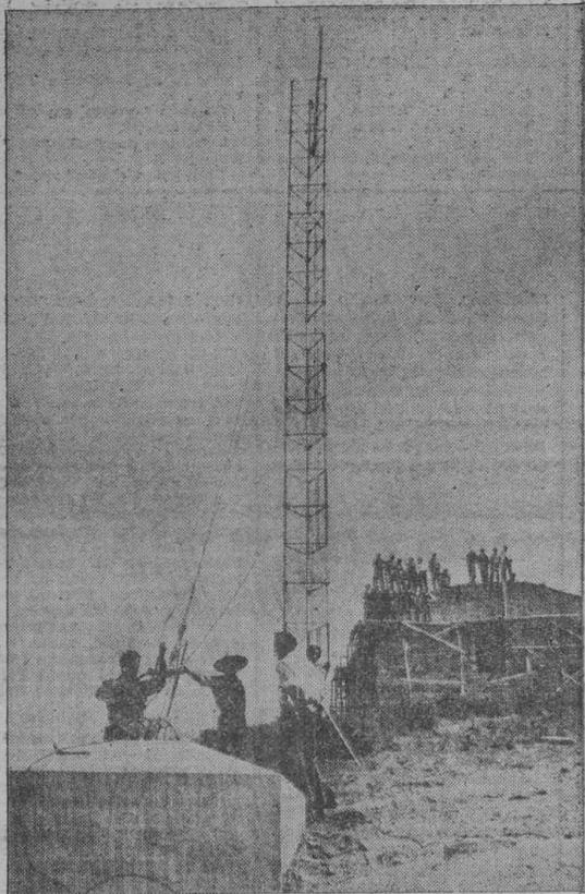
Momento de ser tensado uno de los cables que sujetan la torre antena de la T. V. en el Monte Pedroso
