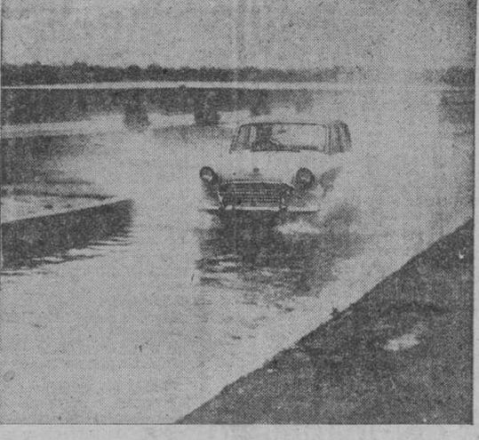
Este charco de agua de 68 metros de largo, situado en las pistas de ensayo de la M. I. R. A., posee a prueba la impermeabilización de los fondos de los vehículos y de sus encendidos.
