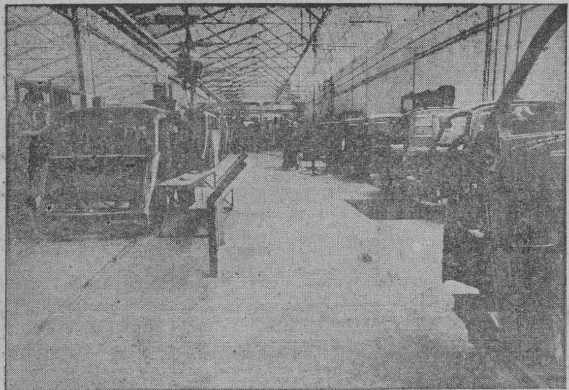
El montaje en serie es fundamental y necesario en la industria automovilística; en España lo realizan varias factorías. Cada operario lleva a cabo una labor, un apriete, un montaje, una soldadura, y mientras tanto la cadena sigue en marcha para que nadie se duerma en su tarea. (Sala de planchistería en la Factoría IMOSA de Vitoria)
