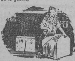
Un planchador electrónico. ¡No—Un encolador electrónico! El nuevo aparato para encolar, el RCA Spot Gluer, proyecta la fuerza electrónica a través del enchapado para calentar la cola y unir las copas de madera. Acelera la producción de aviones de madera y además ofrece grandes posibilidades en la ebanistería y otras industrias análogas.
