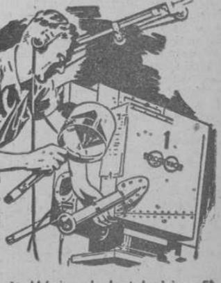
El ojo Mágico de la televisión: El "Iconoscopio", invención de la RCA, hace posible la televisión electrónica. Por medio de millones de células fotoeléctricas «recogen» las imágenes, transmitiéndolas a través del aire mediante las ondas herzianas. Aunque actualmente toda la producción de la RCA se dedica al esfuerzo bélico de las Naciones Unidas, la experiencia obtenida en dicho esfuerzo promete aún mejores productos para usted - cuando venga la Paz!
