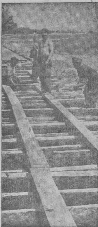
Primeramente, el camino es fijado con troncos, sobre los cuales son colocadas después tablas de madera. De este modo nace una carretera sobre la cual pueden pasar vehículos de ruedas, garantizando el aprovisionamiento.
