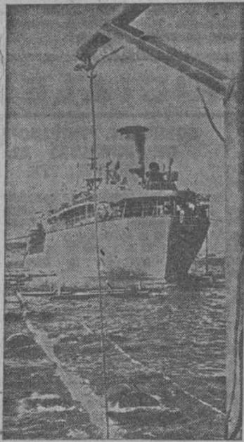
De un petrolero norteamericano, anclado en Italia, se envía la gasolina por medio del oleoducto sostenido por barriles flotantes, a los depósitos de reserva
