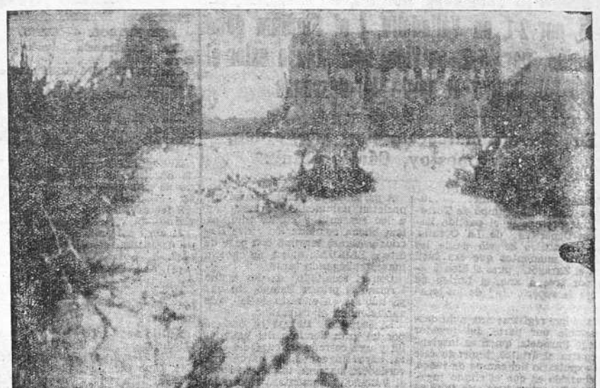
Un aspecto del río desbordado, cuyas aguas llegan hasta las casas
