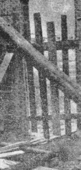
Estado en que quedó la viga de eucalipto cuyo peso determinó el derrumbamiento del piso de una casa en construcción de la Grela, accidente que ocasionó la muerte a un obrero y heridas a otros cuatro. (Foto Artés).
