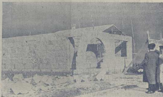
Todos los proyectos se ponen en marcha. Una vista del avanzado estado de las obras de las viviendas de Villajuján
