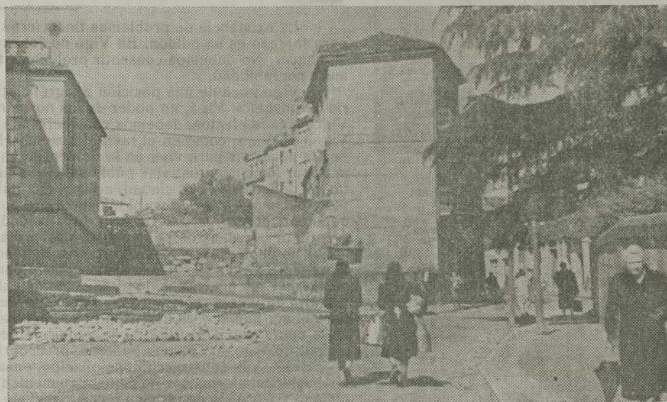
En el progreso urbano de Vigo está llamado a desempeñar un gran papel la nueva red de acceso en torno al Parque del Castro. De ese plan forma parte la calle de la Ronda, que está siendo convertida en excelente arteria del sistema viario interior de la ciudad. Las antiguas construcciones que aparecen en el centro de la postal van pronto a desaparecer para que la Ronda de Don Bosco pueda seguir en recta hasta la Plaza de Granada.
