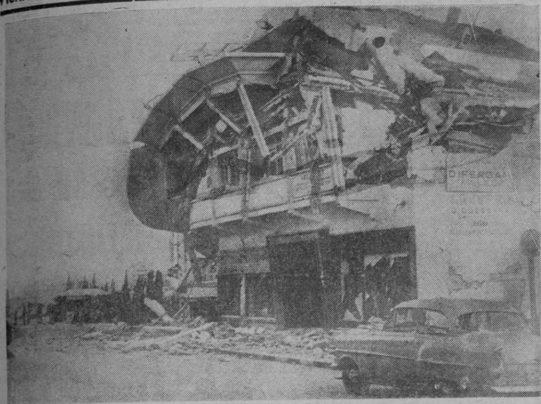
He aquí uno de los edificios de Agadir, totalmente desplazado, de su interior, y pronto a ser demolido, por su insostenible estado.
