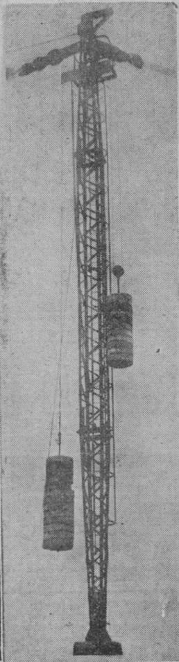
Grúa y transporte aéreo, todo en un sistema mecanizado. Este es el perfil de una de las torres metálicas del Biondin que se utiliza en la construcción del viaducto de La Rocha (Fotos Lavandera)
