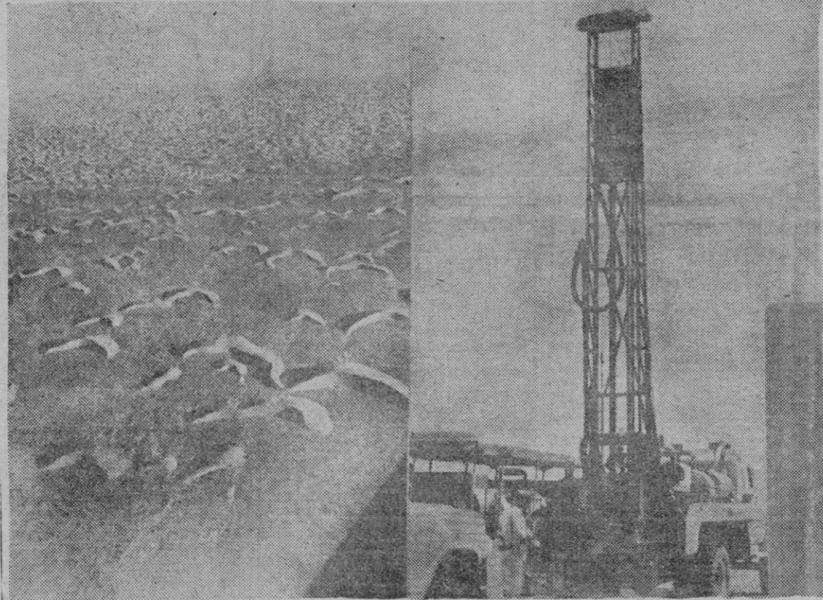
En estas fotografías, las dunas vistas desde un avión y la llegada de la maquinaria para las primeras perforaciones en las cercanías del Aalam, perforaciones que pasan ya de los seiscientos metros. La foto de la derecha recoge el aspecto de una de las torres de perforación sobre un camión especial.
