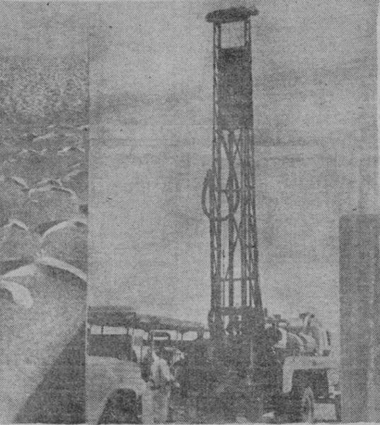
En estas fotografías, las dunas vistas desde un avión y la llegada de la maquinaria para las primeras perforaciones en las cercanías del Aalam, perforaciones que pasan ya de los seiscientos metros. La foto de la derecha recoge el aspecto de una de las torres de perforación sobre un camión especial.
