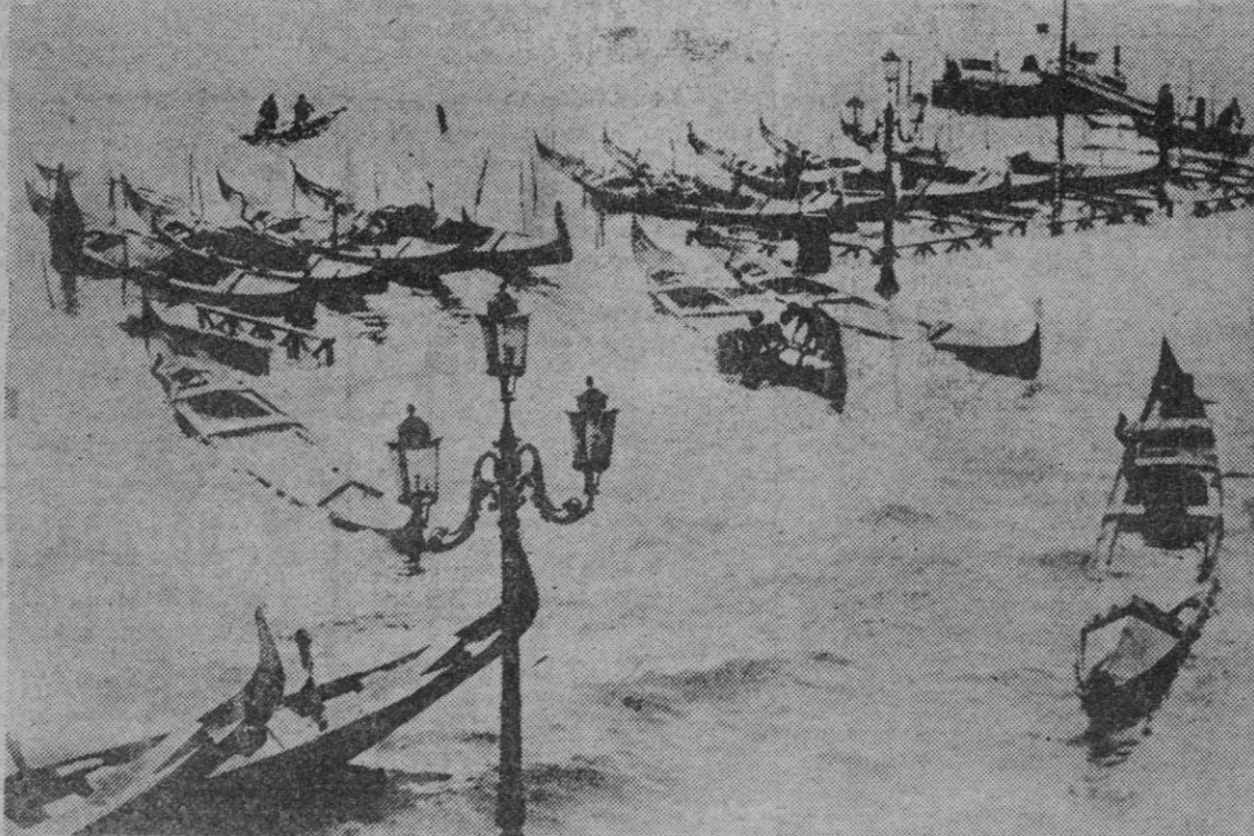
En Venecia el agua es algo natural, y la ciudad de los canales debe a ella su singular fisonomía. Pero, a veces, el agua no se conforma con seguir su cauce, camino urbano de las gondolas, y hace de las suyas, como en esta ocasión, en que ha dejado convertida en mar la famosa plaza de S. Marcos
