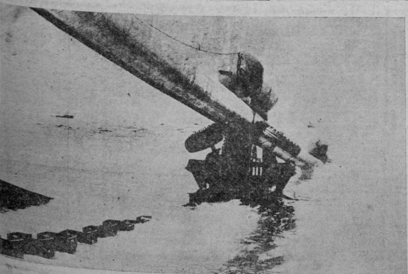
Uno de los dos oleoductos submarinos que han sido lanzados en las costas próximas del Havre, para permitir a los petroleros descargar a lo largo de la costa normanda. Su inmersión se realiza entre dos cortinas de planchas protectoras
