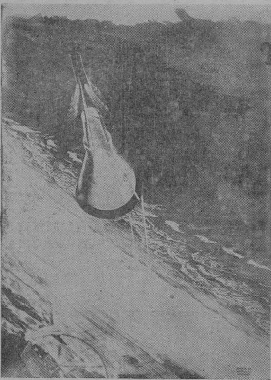
Un dibujante ha presentado la forma en que la cápsula del "Atlas" regresaría a la Tierra en el caso de que no lo fuera por ser colocada en órbita. Los cohetes colocados en la parte superior de la cápsula serían puestas en acción y la cápsula, con su ocupante, descendería hasta una altura adecuada para desplegar un paracaídas. (Foto E. Press)
