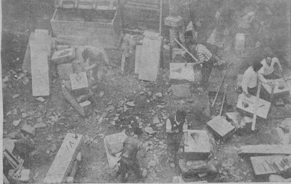
Obras de pavimentación en la Algalia de Arriba.
