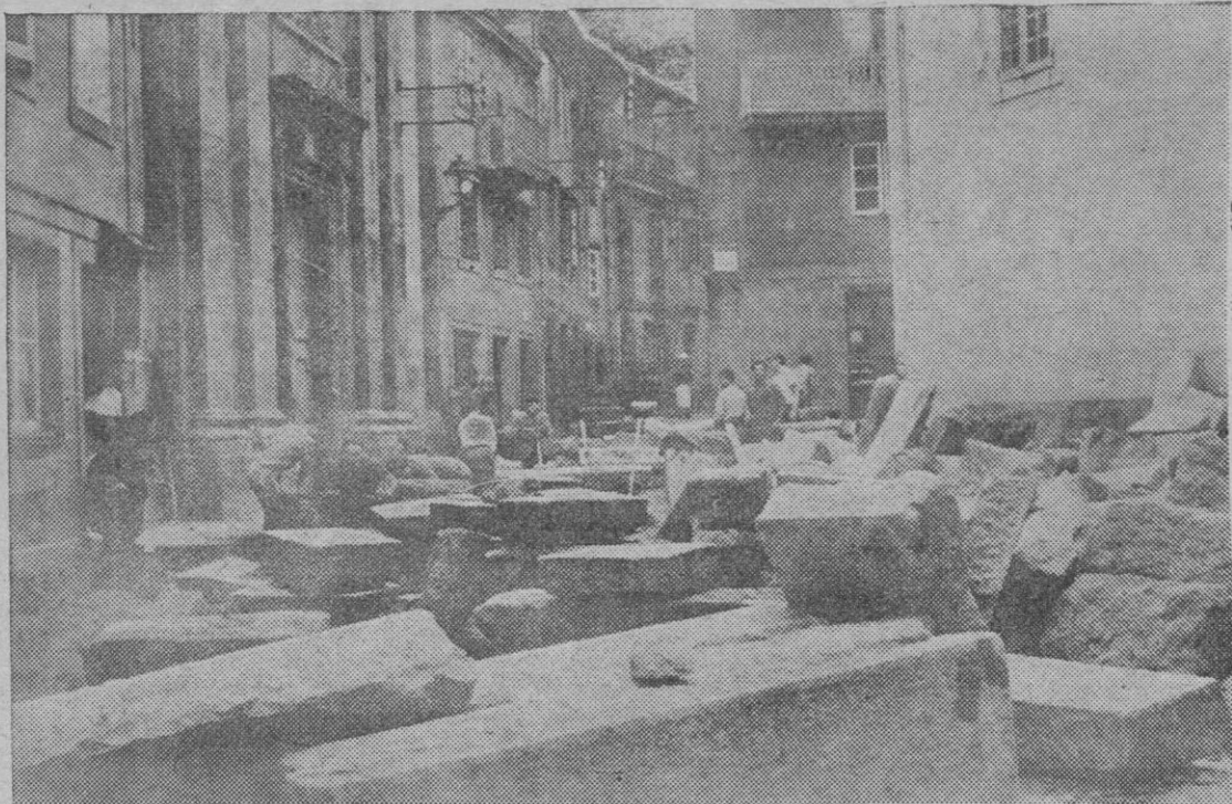
La Rúa Travesa en obras. — (Fotos LAVANDEIRA)
