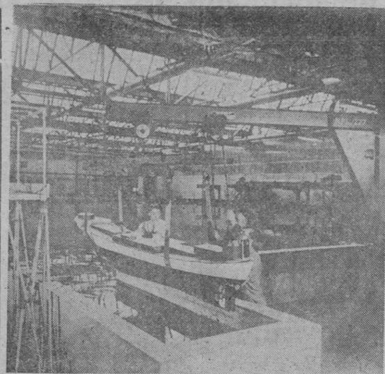
Preparando el lanzamiento del modelo de un barco de pesca de altura en el tanque hidrodinámico.
