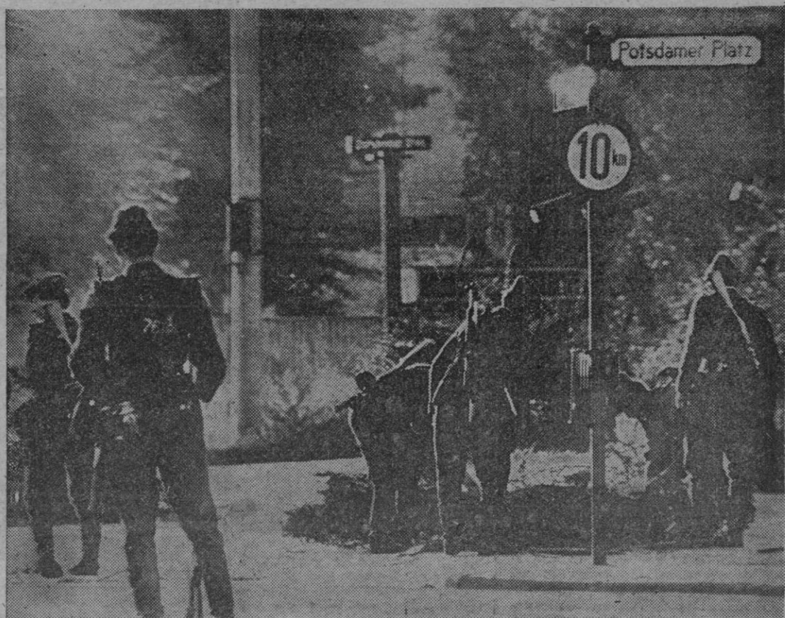
BERLIN — Postes de hormigón armado y alambre de espino en cantidades enormes han sido utilizados por los rusos, y los alemanes orientales para interrumpir el exodo de la población hacia el Berlín libre. Cerca de la Plaza de Potsdam una patrulla de soldados orientales preparan la cerca para impedir las fugas (Foto Europa Press)
