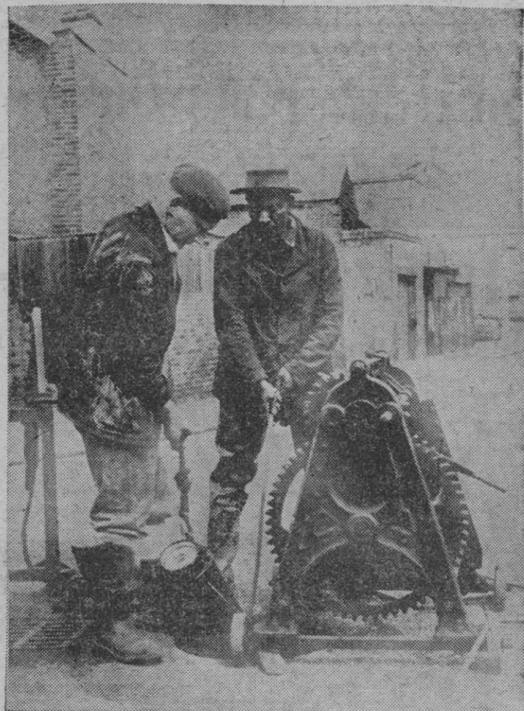
Colocación de una cámara televisora en una alcantarilla, durante una demostración hecha recientemente en Londres, a fin de inspeccionar el alcantarillado y localizar las averías
