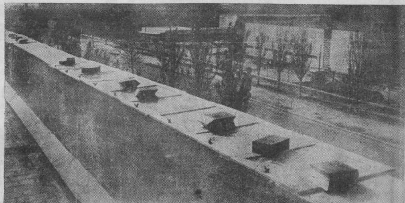
En la fotografía, un detalle de los aparatos encargados de recoger el polvo radiactivo del Centro de Energía Nuclear de Madrid
