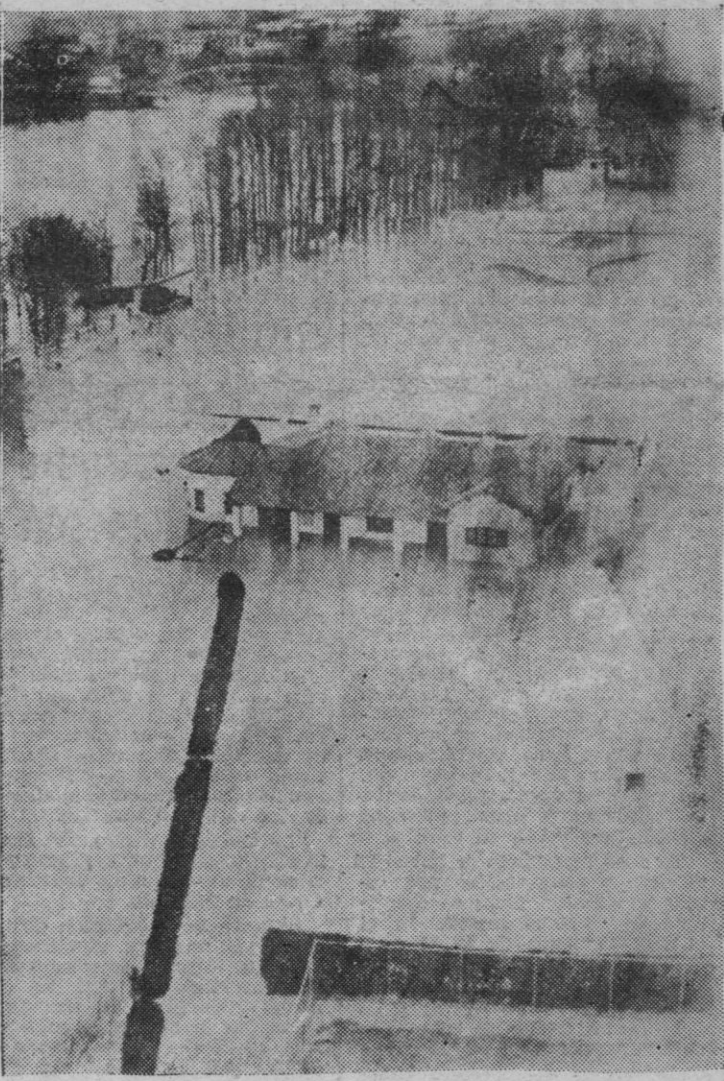
VALLADOLID. — Las aguas del Pisuerga llevaban un nivel de ocho metros por encima del normal a su paso por esta ciudad. El nivel se podía apreciar en el Puente Mayor. Cerca de este puente había varias casas inundadas. La carretera Madrid - León estaba cortada junto al puente del Pontón. — (Foto Europa Press)
