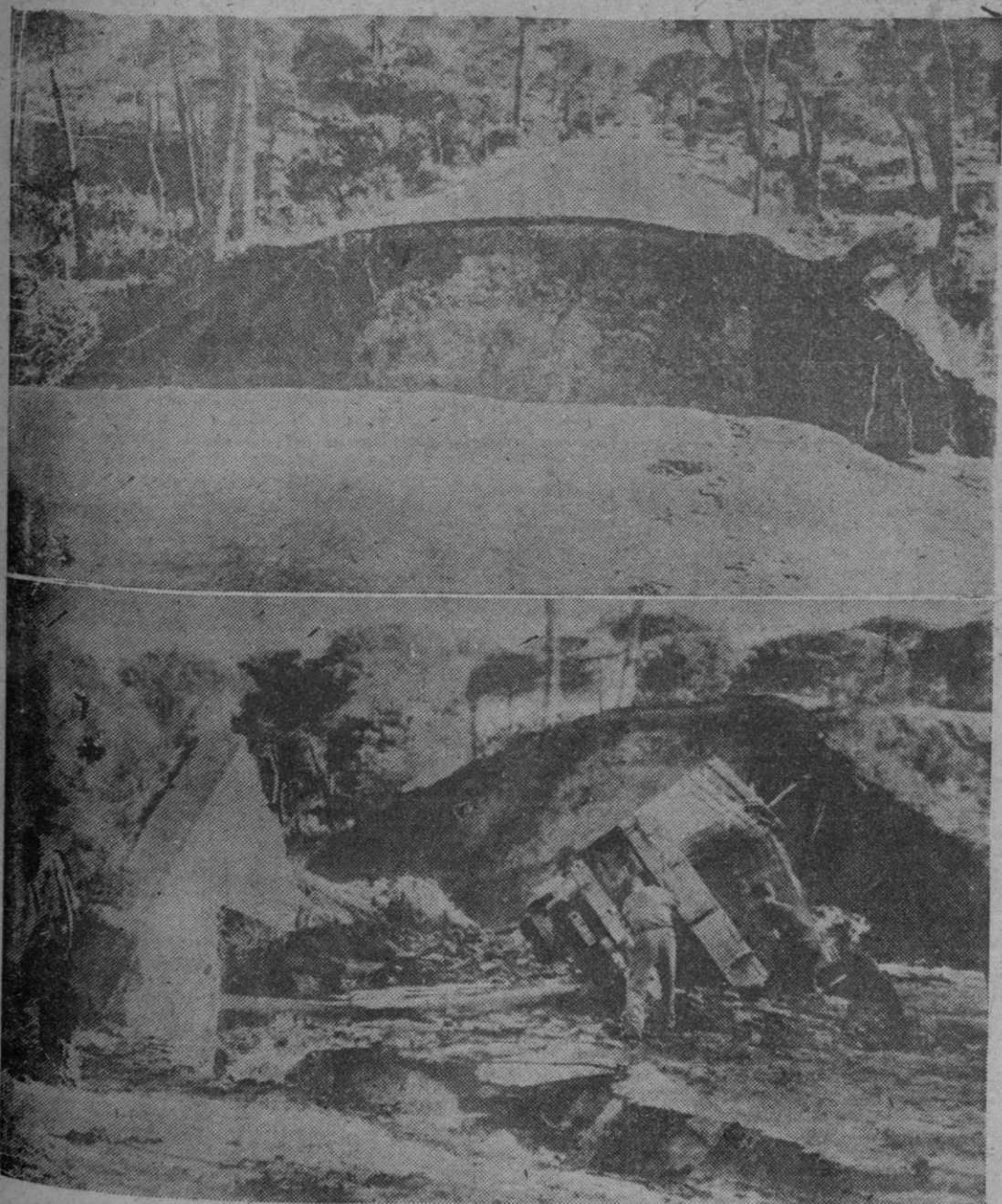
El camión matrícula de Madrid 281378 acertó a pasar en el justo momento en que la carretera, reblandecida por las incensantes lluvias, se hundía. Fue en la carretera de Sevilla a Ayamonte, en el lugar comprendido entre las localidades de Lepe e Isla. Siete metros de profundidad y doce de longitud mide el hundimiento, dimensiones que se comprenden porque bajo aquel tramo de la carretera existía una alcantarilla. En la primera de las fotografías se recoge una vista de la situación en que quedó el trozo de carretera; en la segunda, los trabajos que fue preciso realizar para rescatar el camión de la trampa en que había caído. No hubo que lamentar, afortunadamente, víctimas personales.
