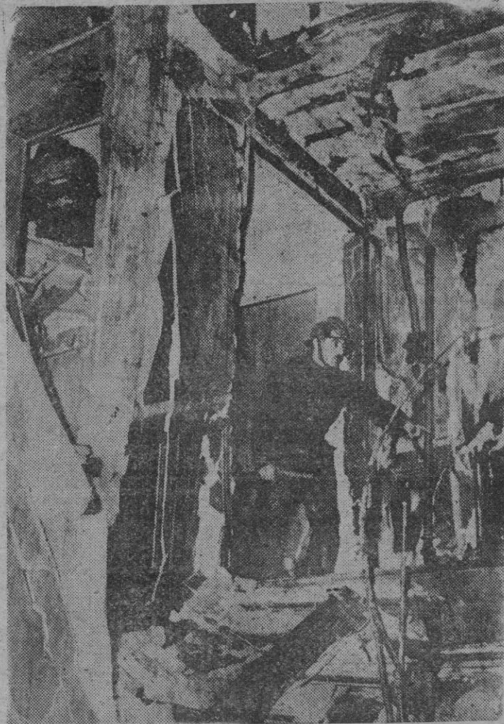
Así quedó la casa en la que vive Jean Paul Sartre después de haber explotado en ella el "plástico" destinado al hombre de letras. El edificio está enclavado en el barrio de Saint Germain des Pres. No hubo víctimas; destrozos, no hay más que verlos.
