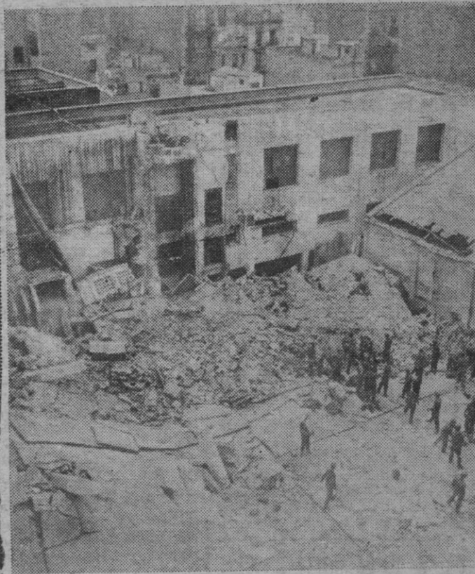
BARCELONA. — El derrumbamiento de una nave que formaba parte de una fábrica de seda cuya fundación data del año 1840 ha ocasionado seis muertos y 10 heridos, todos ellos obreros de los telares cuyo número en el momento del derrumbamiento era sólo de veinte, con lo cual el número de afectados es sólo el que resenamos anteriormente. En la foto, un momento de los trabajos de descombra. — (Foto Europa Press)
