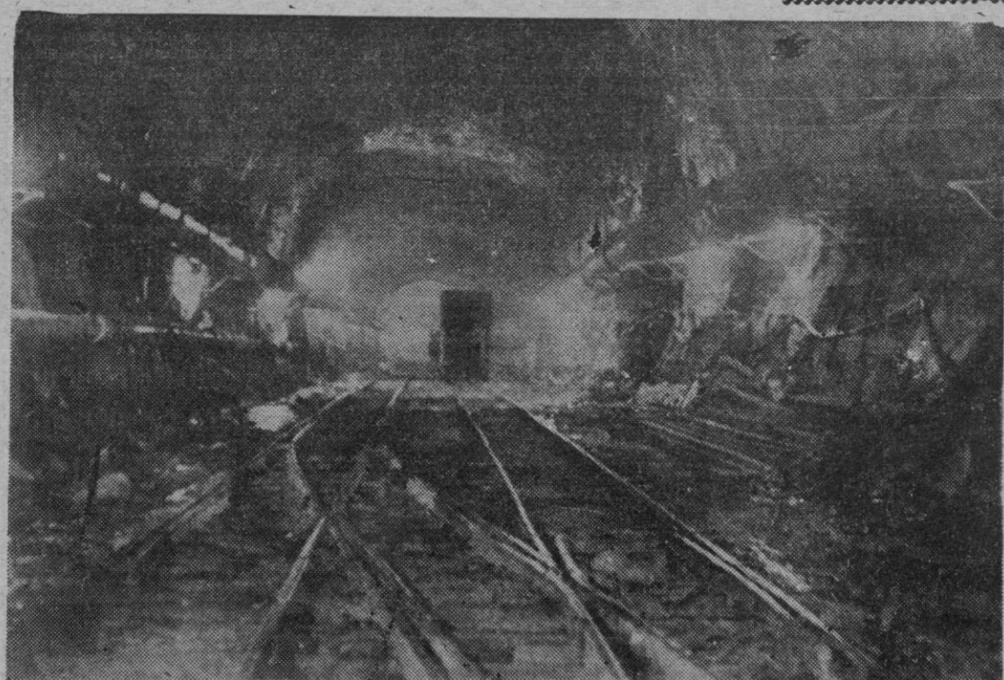
CHAMBERY.- Una vista del interior del túnel del Montblanc, en el lado francés. En el interior funcionan pequeños trenes eléctricos para el transporte de los obreros, del material y para sacar al exterior las grandes rocas que están siendo extraídas. En el interior del túnel hay establecidas unas extraordinarias medidas de seguridad y de disciplina al objeto de evitar accidentes. (Foto Europa Press).
